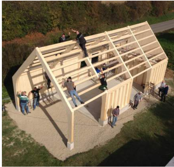
Tolles Wetter beim Aufschlagen der Hütte
